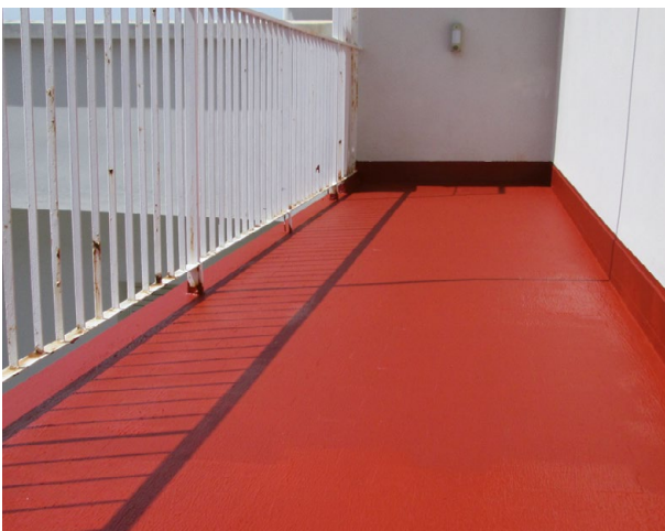
4. Lavoro finito. Possibilità di: a) pavimentare con piastrella b) rivestire con strato pedonabile antiusura in resina ACRYTOP c) lasciare a vista
