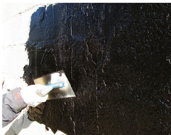
● DERMARUBBER S: applicazione a spatola su muro di fondazione con forti porosità
