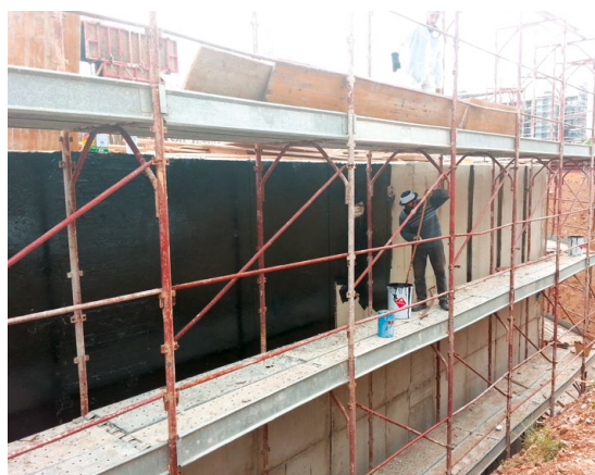
● DERMARUBBER S/P: applicazione a rullo su setti di fondazione in cls
