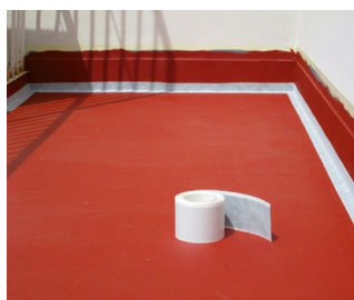
3. Impermeabilizzazione giunti e raccordi con CASABAND SA
