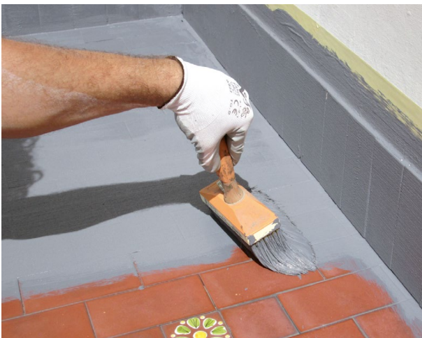
1. Applicazione di primer MULTIFIXO 100 su balcone pavimentato
